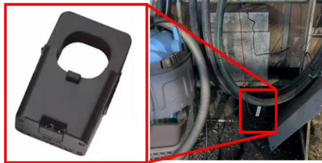
<電流センサの配電盤への設置>
